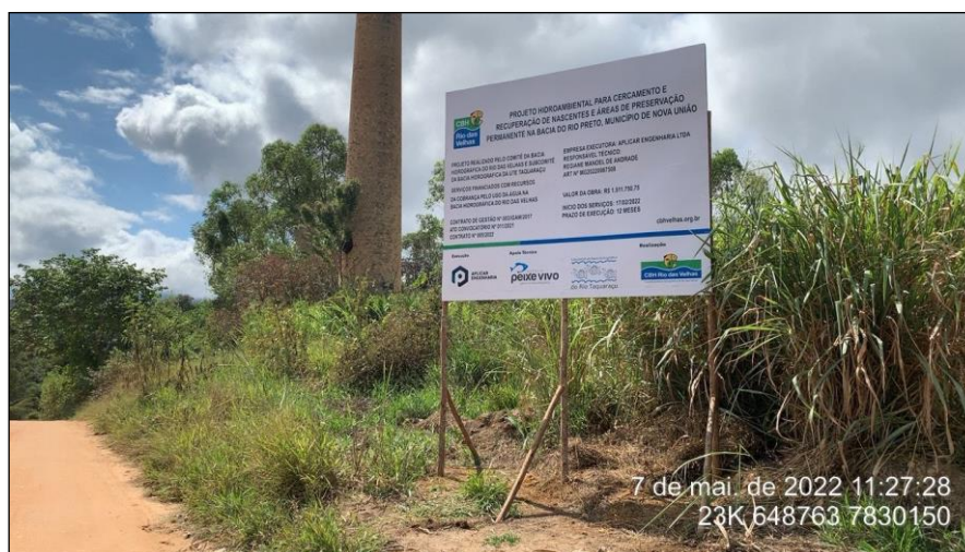
Figura 3 - Instalação das Placas de Obra. Fonte: Aplicar Engenharia, 2021
